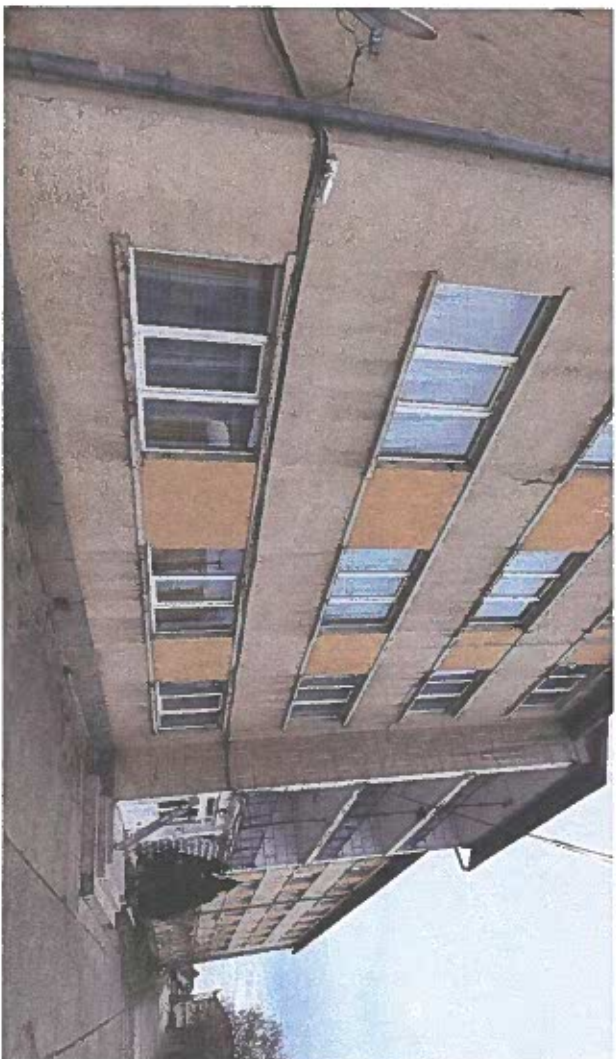
Poza 1. Fatada principala. Se observa unele infiltratii la soclul Anexei
