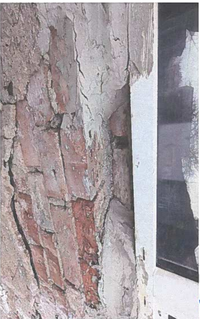
Poza 9. Fatada spre str. Electricienilor. Se observa lipsa trotuarului si portii la tencuiala cazuta
